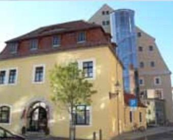
Rückseite des historischen Salzhauses, mit neuem Fahrstuhlgebäude
